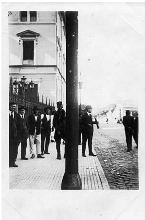
Figura 1 - Posto de energia marcado por tiros
