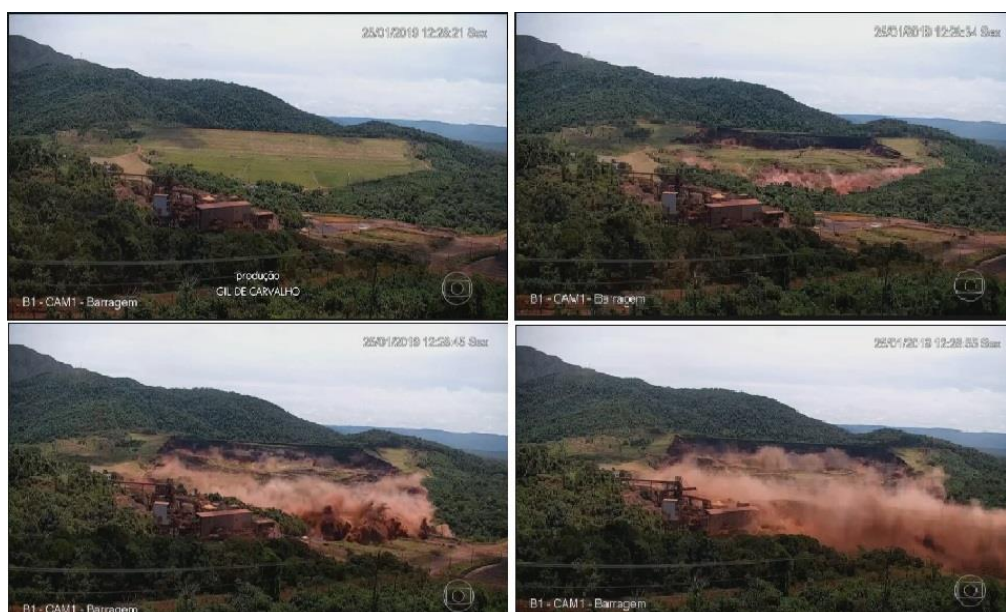
Figura 1 - Câmera de videomonitoramento da Vale registra momento exato do rompimento da Barragem I da Mina Córrego do Feijão, em Brumadinho (MG).
